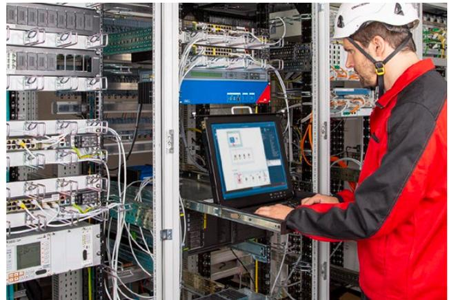
Abb. 3: StationGuard importiert die SCL-Datei der Schaltanlage und erzeugt auf deren Basis ein komplettes Modell des Systems
